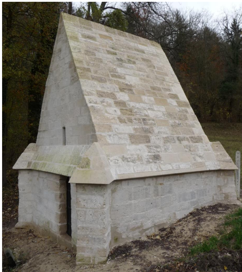
Regard de fontaine à Pont-Sainte-Maxence
